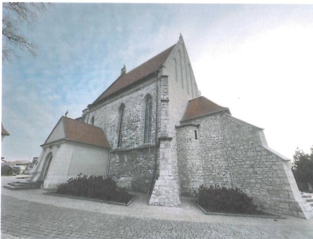
Fot 2. Stan zachowania elewacji – fragment
