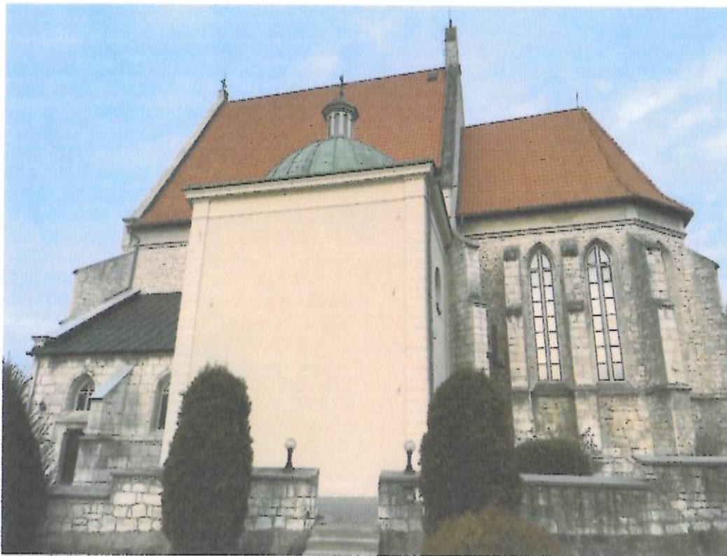
Fot.1. Elewacja kościoła, widok ogólny - stan zachowania
